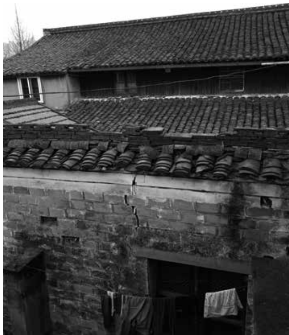
趙氏三傑祖居後面院牆原計原味，二樓保存較完整
