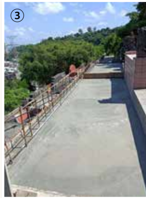
③、走道灌水泥完成。
