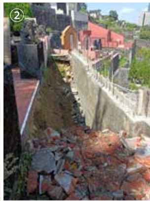
②、施工中的擋土牆完成。
