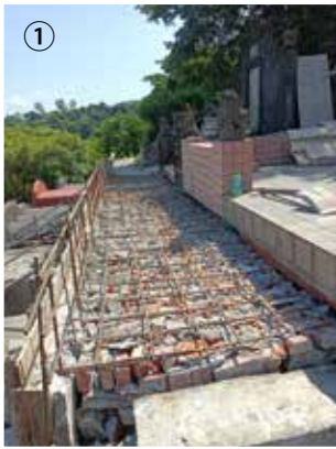
①、三張犁墓園修繕擋土牆回填及綁鋼筋完成。
