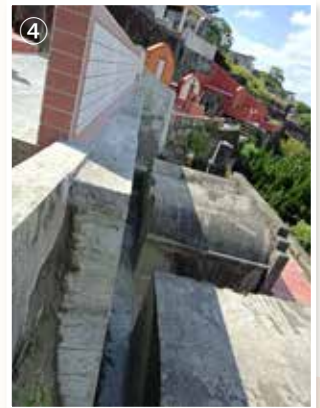
④、下方墓區和擋土牆及部分護欄完成全景。
