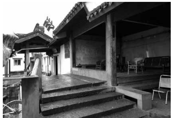
陳撰故里的跨涇橋既是橋又是涼亭戲臺，一橋兩用十分罕見。
